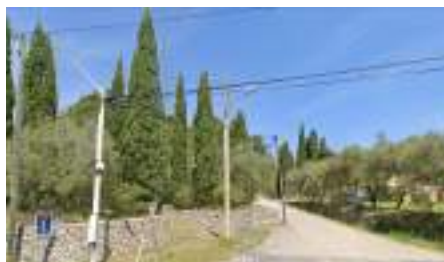
Murets protégés, entrée Sud de Favas
