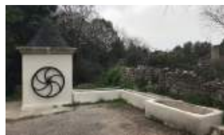
Puits communal - Agence R&C
