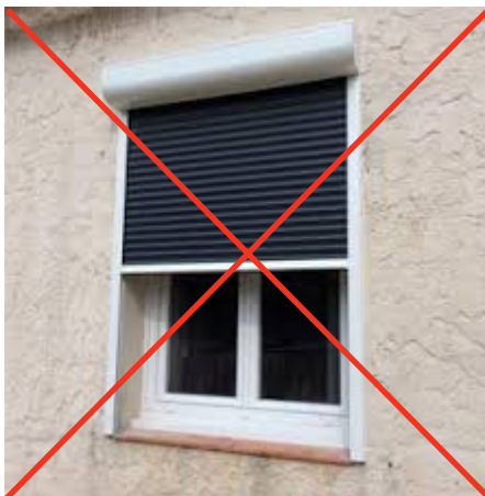
Exemple de dispositifs apparent d'enroulement des volets interdit
