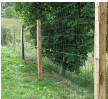
Exemple de clôture autorisée : grillage souple à large maille et piètements bois
